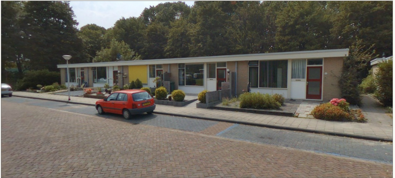
Koolzaadhof, senioren-woningen, overgang
